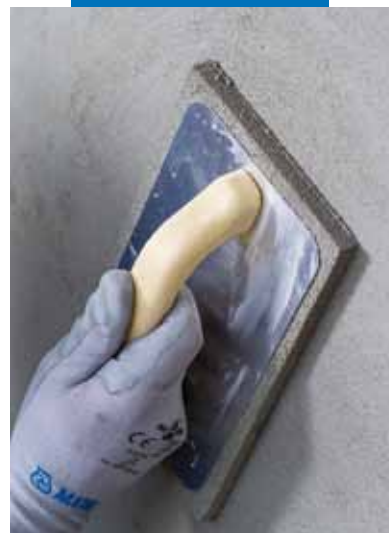
Frattazzatura di Planitop Rasa & Ripara R4
